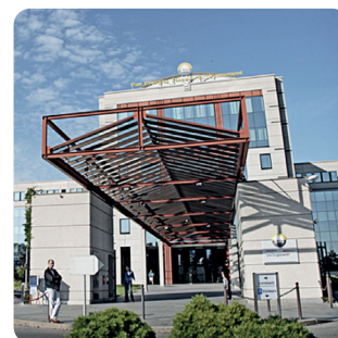
SIG Energieservices | CH
